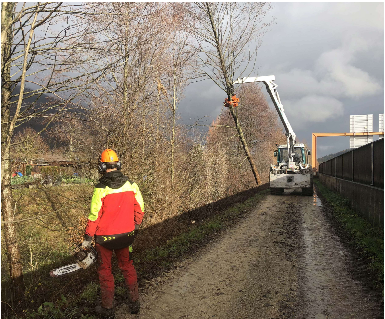
Unterhaltsarbeiten – Auslichten der Erlen
