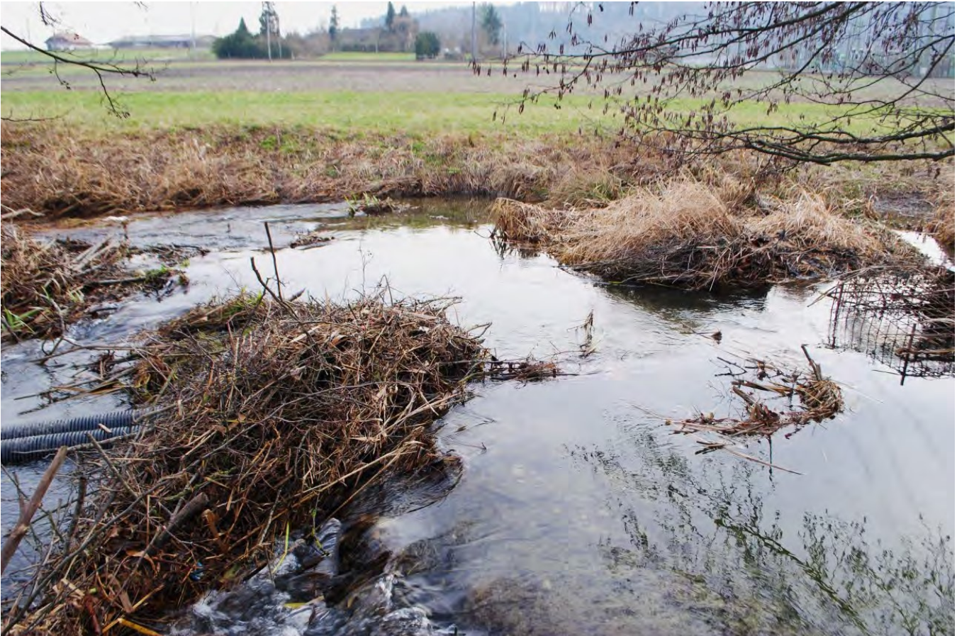
Überlauf vom Damm
